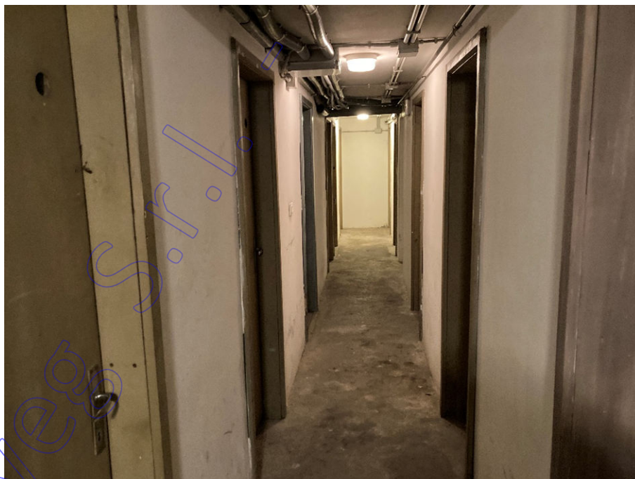
Vista interni scantinato
